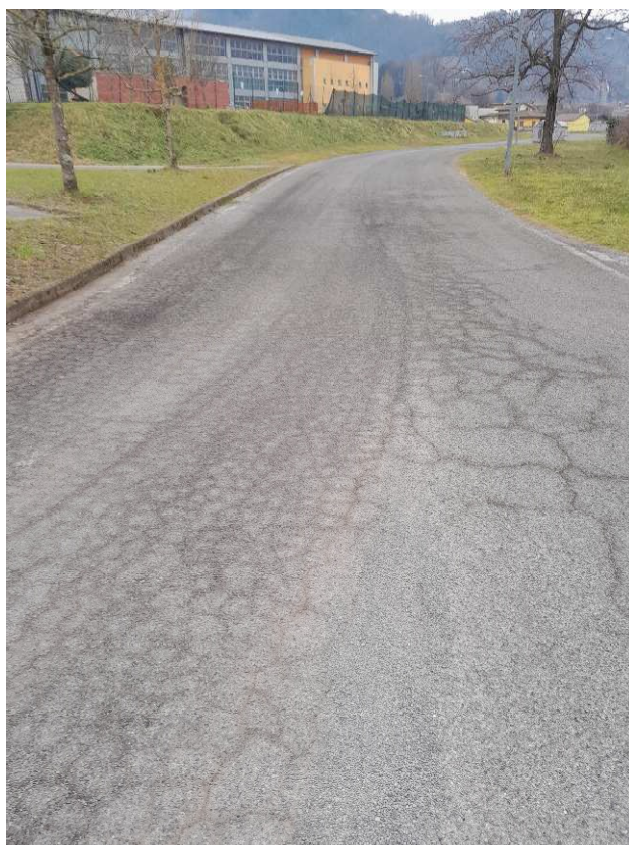
Foto 1 - tratto di strada esistente
