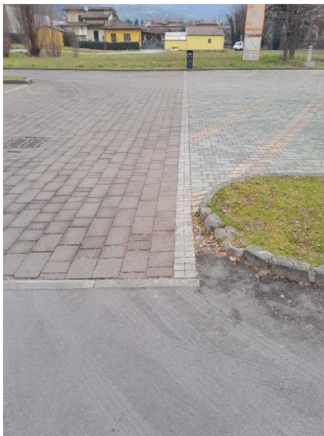
Foto 9 - parcheggio - tratto terminale del nuovo tracciato
